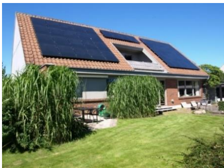
Vores hus med solceller.
