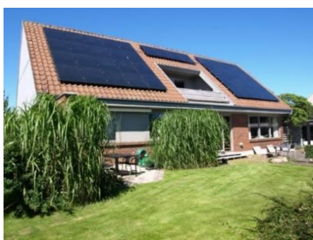
Vores hus med solceller.
