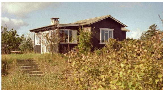
Sommerhuset har nu fået pejsestuen med skorsten.
