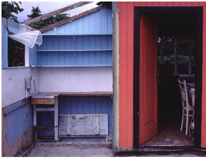
Det lyseblå køkken, hvor væggen ind til pejsesluen og taget allerede er fjernet.
